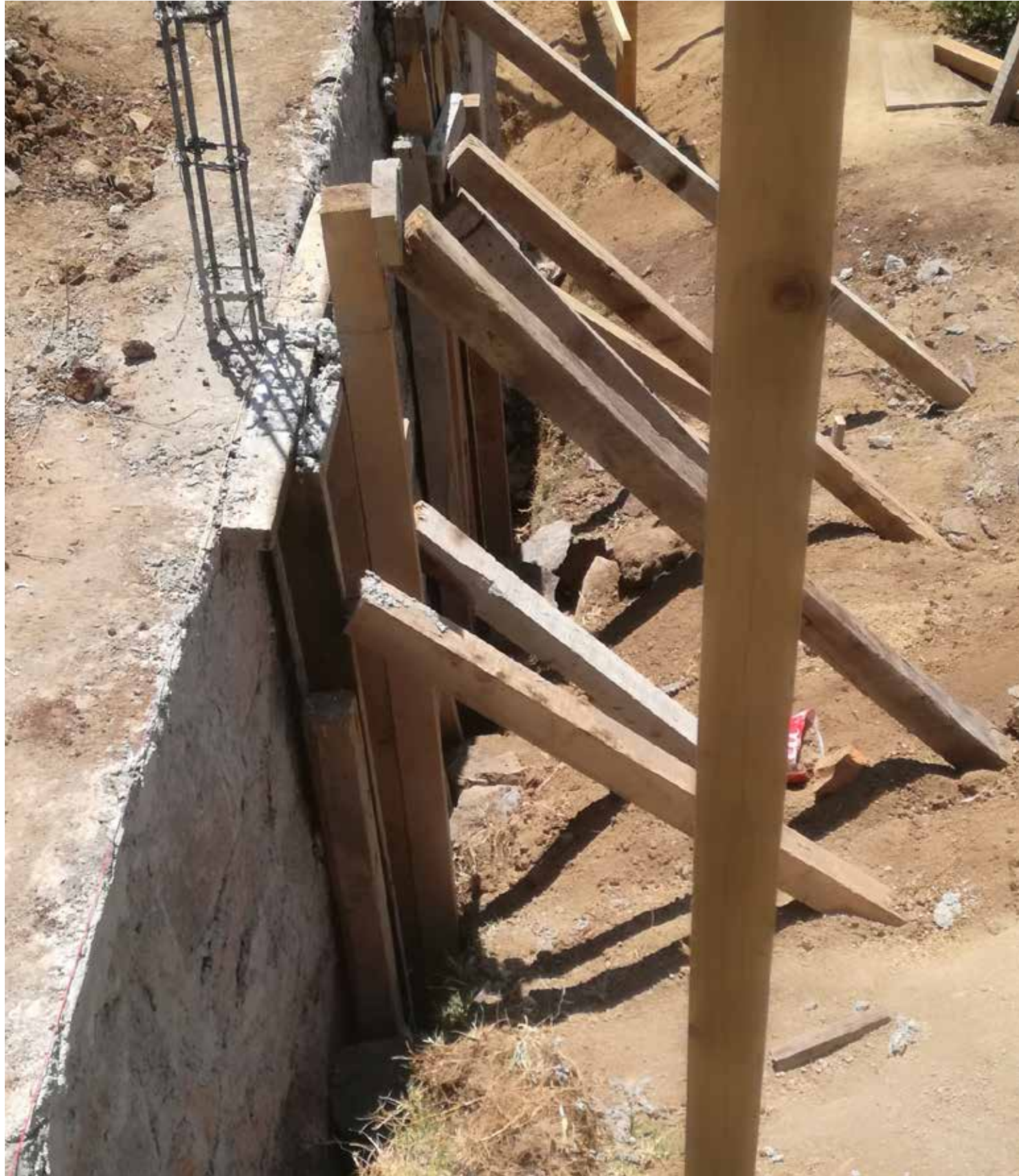
Se realizó la construcción de la BARDA PERIMETRAL EN EL PANTEON , con una inversión de $3,000,000.00 en las comunidad de San Agustín Mextepec.
